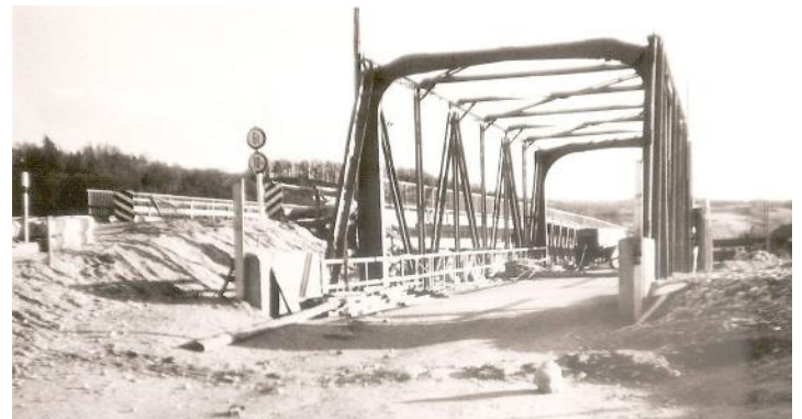
Abbruch der Behelfsbrücke nach Inbetriebnahme der neuen Isarbrücke
