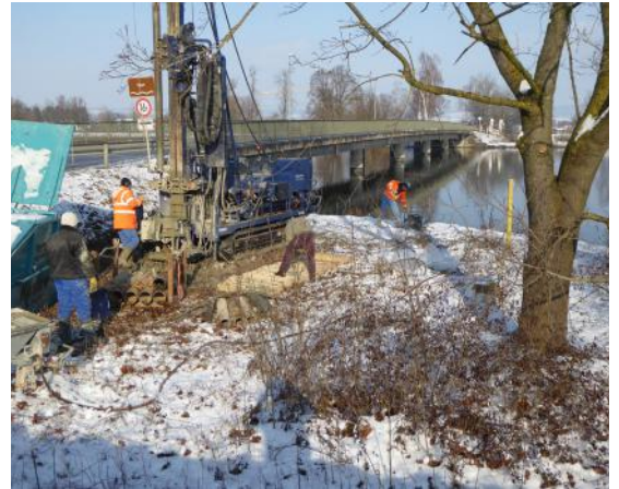
Bei Rammsondierungen wurde der Untergrund möglichst genau erkundet.
