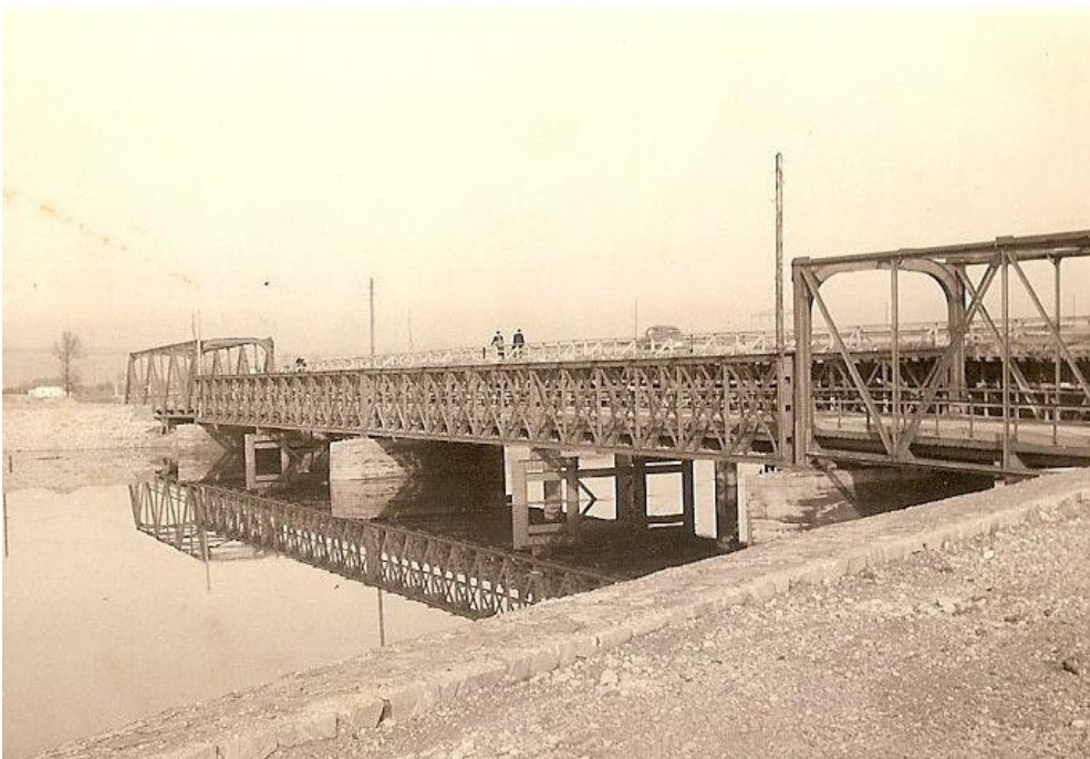
Die notdürftig reparierte alte Eisenbrücke
