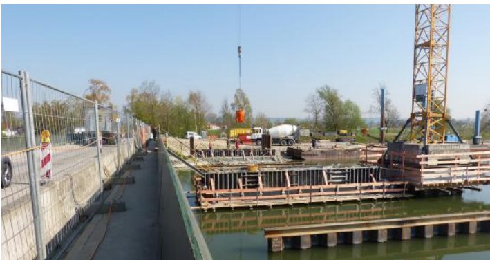
Die Widerlager und Pfeiler in der Behelfslage werden betoniert.
