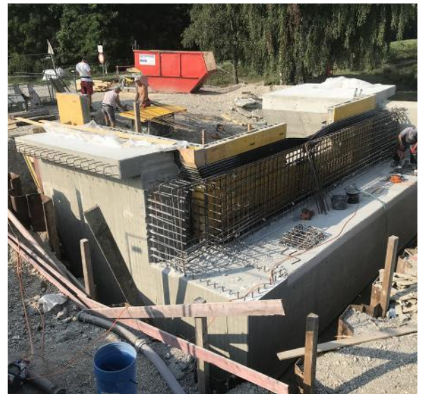
Beton- und Schalungsarbeiten am Widerlager Süd.
