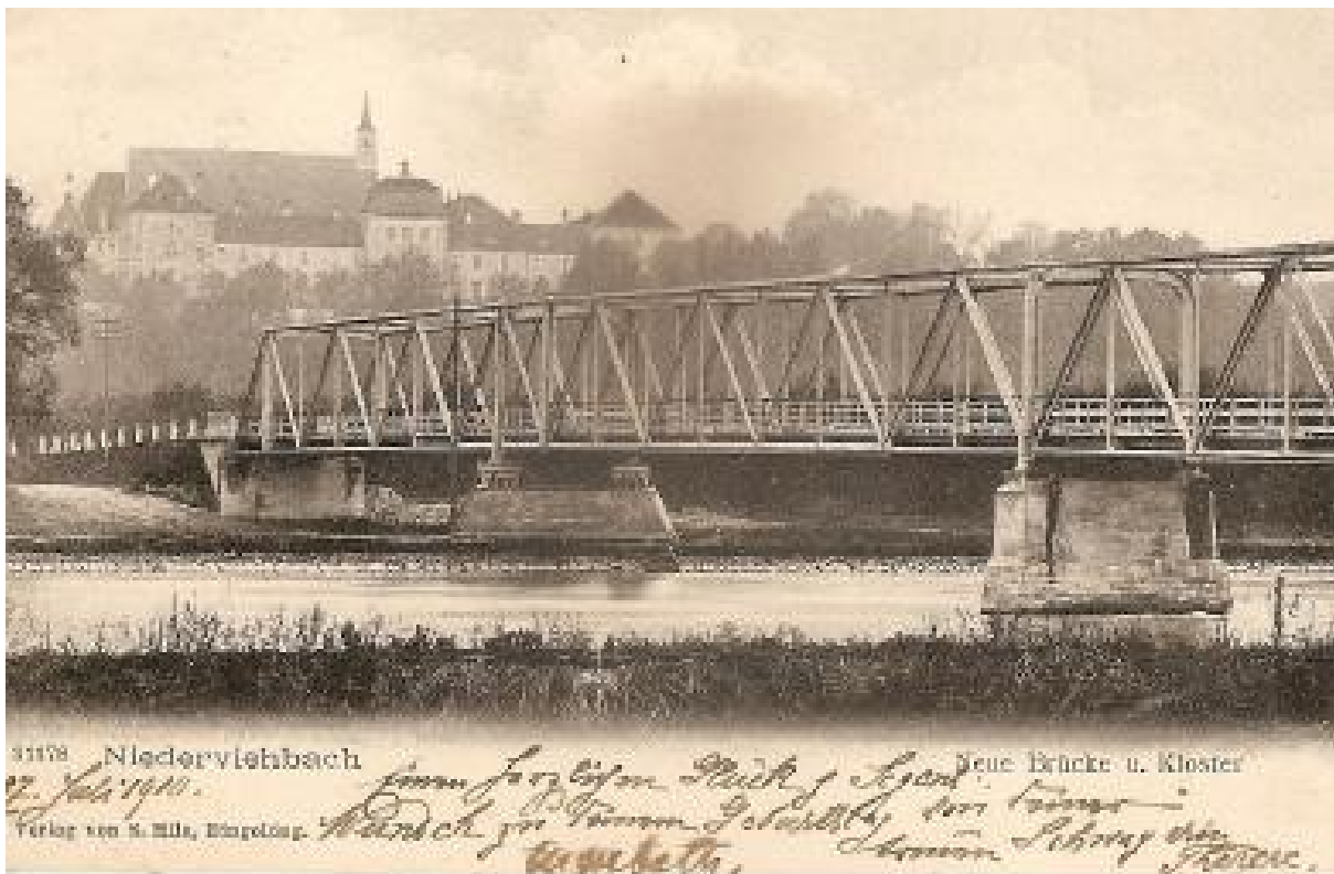
Ansichtskarte von Niederviepbach 1904 mit der neuen Brücke und dem Kloster
