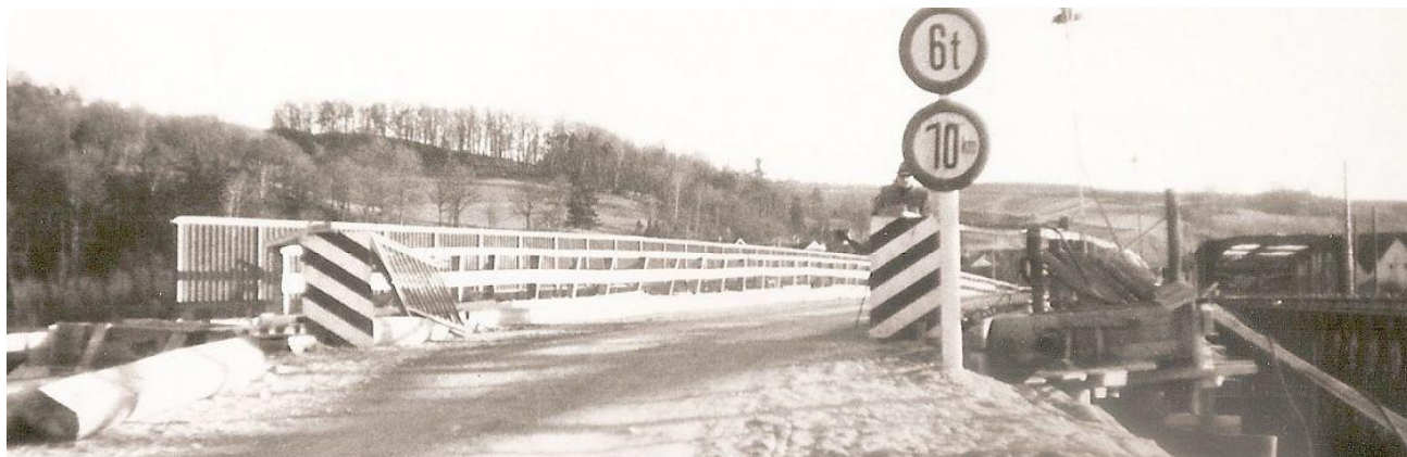
Die fertige Isarbrücke mit provisorischer Auffahrt
