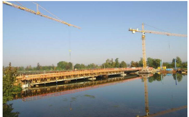
Bauabschnitt 2 (Seite Niederviehbach)
