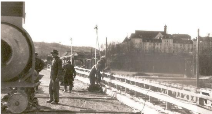
Brückenbau mit großen Betonmischmaschinen in Handarbeit im Jahre 1956
