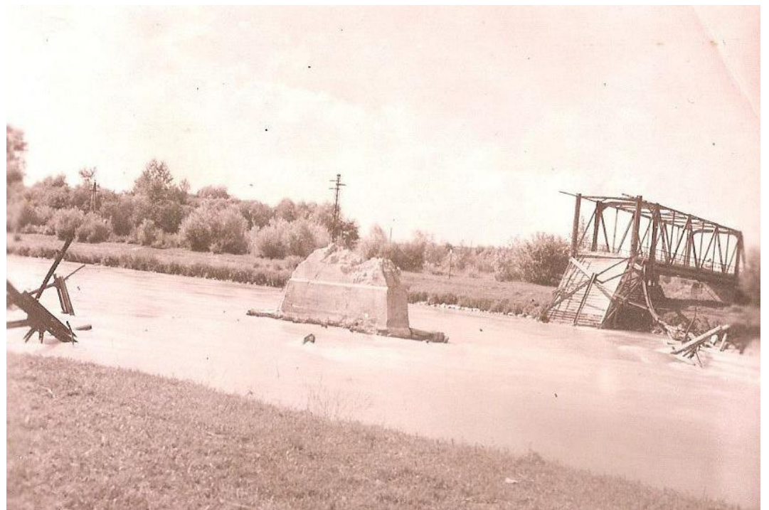
Brückenköpfe blieben nach Sprengung noch intakt
