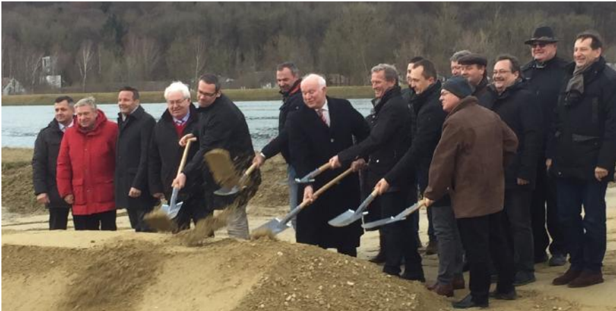
Am 12. Dezember 2017 erfolgte im Beisein zahlreicher Ehrengäste der Spatenstich für die neue Brücke.
