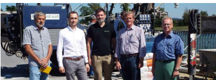
Von der alten Brücke aus wurden 2016 Bohrungen zur Baugrunderkundung durchgeführt. Die Vertreter von Bauherren, Planungsbüro, Baugrundgutachter und Bohrfirma trafen sich vor Ort.
