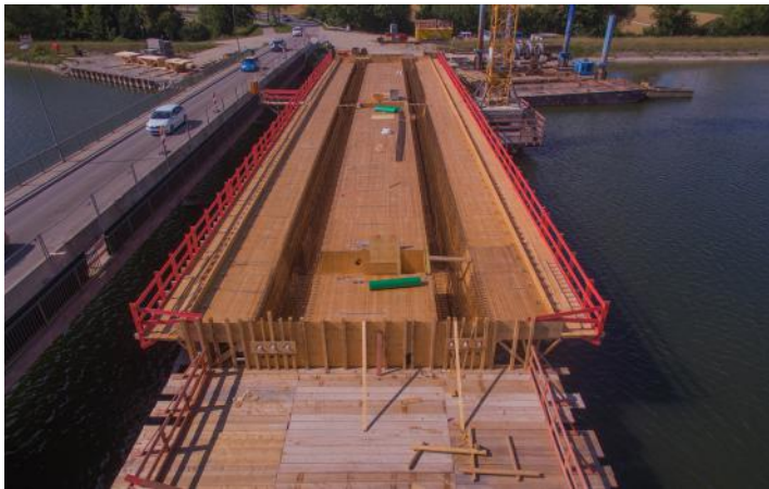
Die fertige Schalung für den Abschnitt 1 des Überbaus
