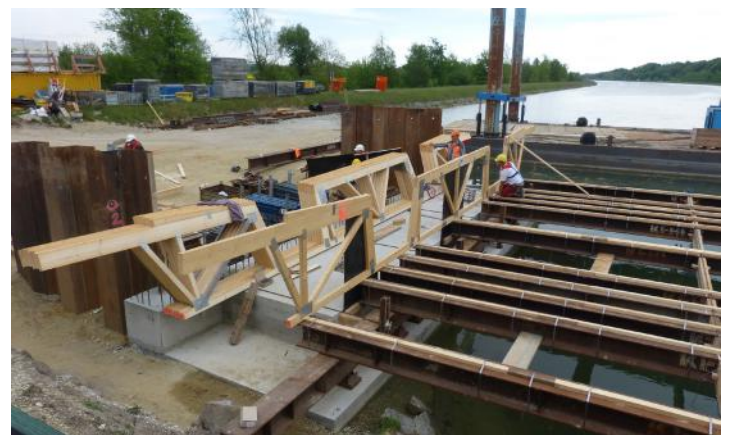
Schalungsarbeiten für den Abschnitt 1 (Seite Lichtensee) des Überbaus.
