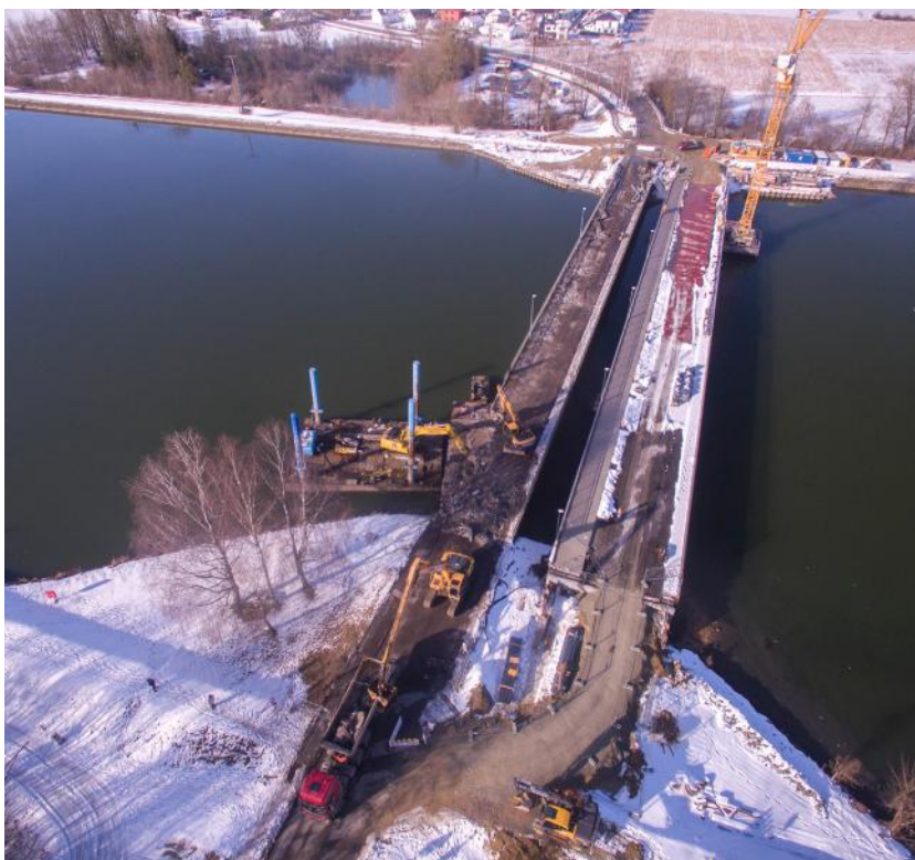
Im Winter 2019 sind die alte und die neue Brücke gesperrt (links) Die neue Brücke konnte nicht mehr rechtzeitig asphaltiert werden, das alte Bauwerk wird bereits abgebrochen. - oben: Abbruch der alten Brücke. - rechts: Bürgermeister Johannes Birkner und Landrat Heinrich Trapp
