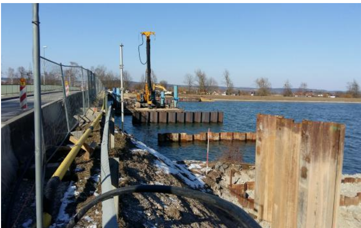
Spundwandaarbeiten für die Pfeiler der neuen Brücke in der Behelfslage.
