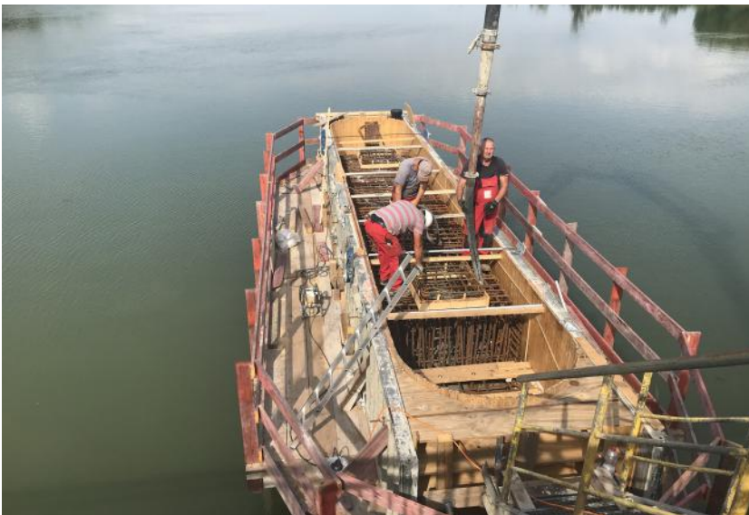
Die Flusspfeiler in der Endlage werden betoniert.
