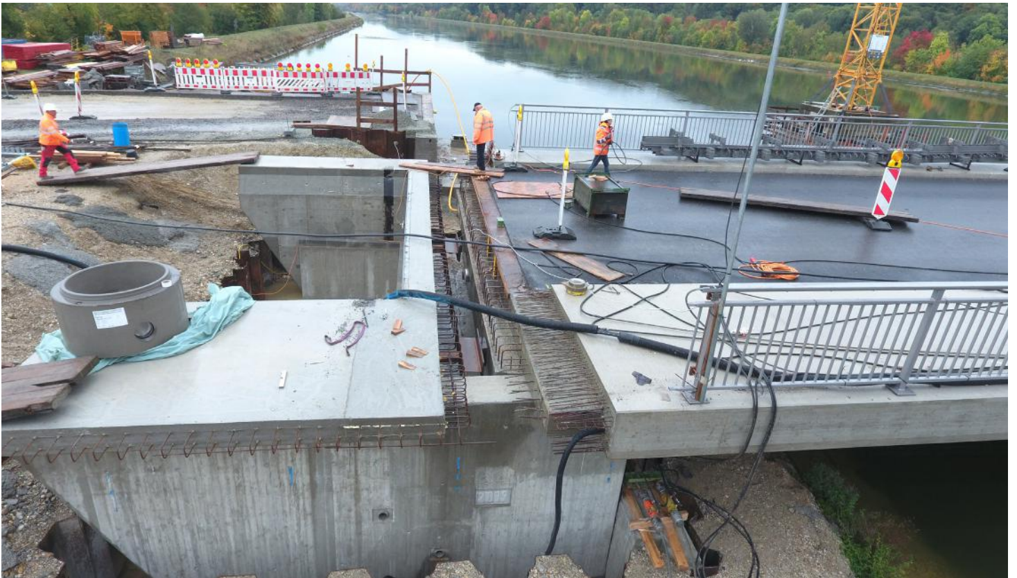
Schließlich war es geschafft: Nach rund 14 Metern hat die neue Brücke ihre endgültige Lage erreicht.
