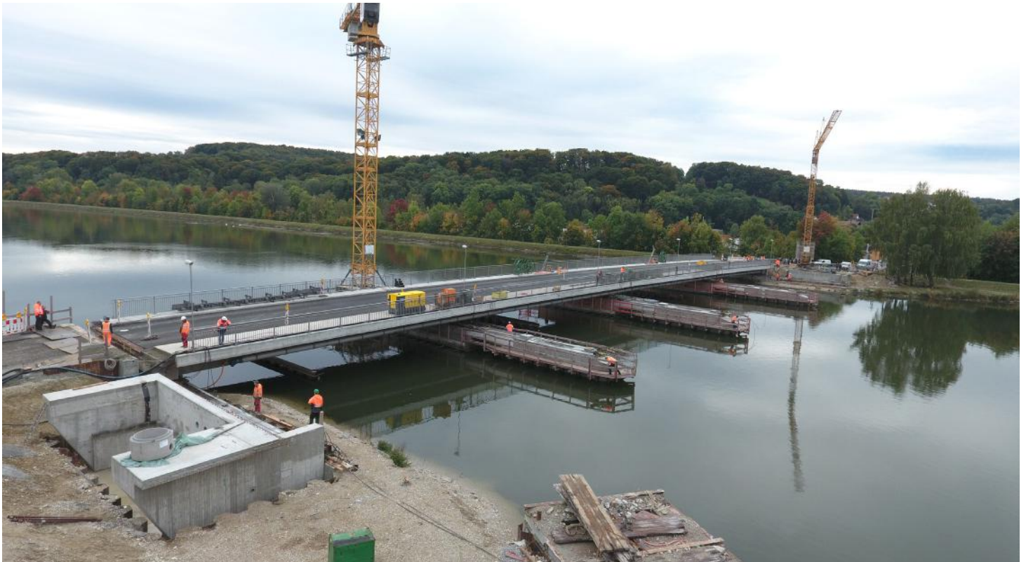
Im Oktober 2019 erfolgte der Vershub der neuen Brücke von der Behelfslage in die Endlage, auf dem Bild noch in der Behelfslage.
