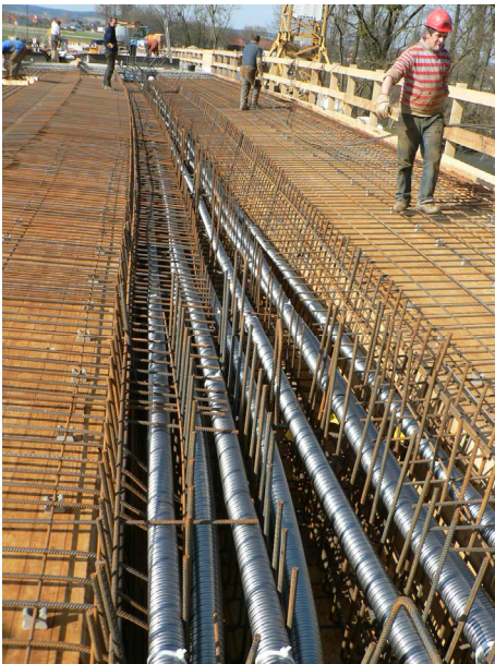
Links: Bewehrungsarbeiten mit fertig verlegter Spannbewehrung (06.04.2009)
