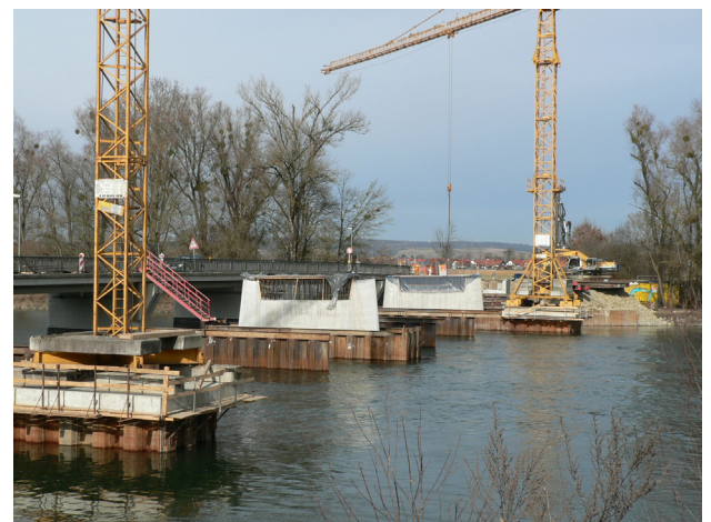
02.02.2009: fertiggestellte Unterbauten
