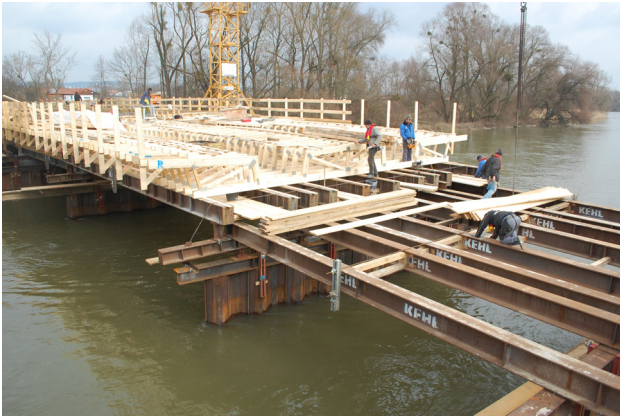
12.03.2009: Traggerüst und Schalung Überbau
