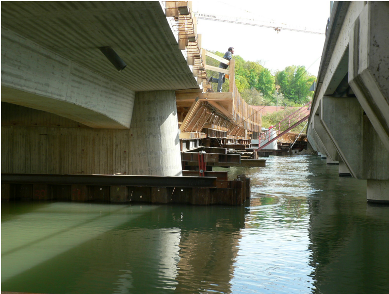
20.04.2009: Untersicht Überbau BA 1 fertig, BA 2 engerüstet.
