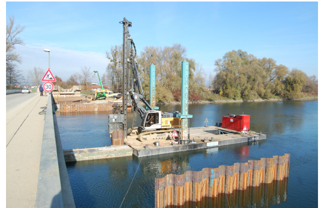
10.11.2008: Spundwandrammen Pfeiler 30 vom schwimmenden Ponton aus
