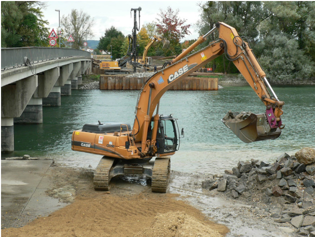
01.10.2008: Spundwandkasten Pfeiler 40 fertig, Spundwand Widerlager Kronwieden in Arbeit, Aushubarbeiten Pfeiler 20
