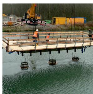
Setzen der Pfeiler - das Fundament der Brücke.
