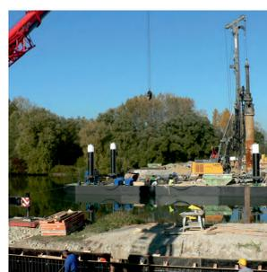
Die Großbohrpfähle für die Pfeiler werden von einem schwimmenden Ponton aus eingesetzt.
