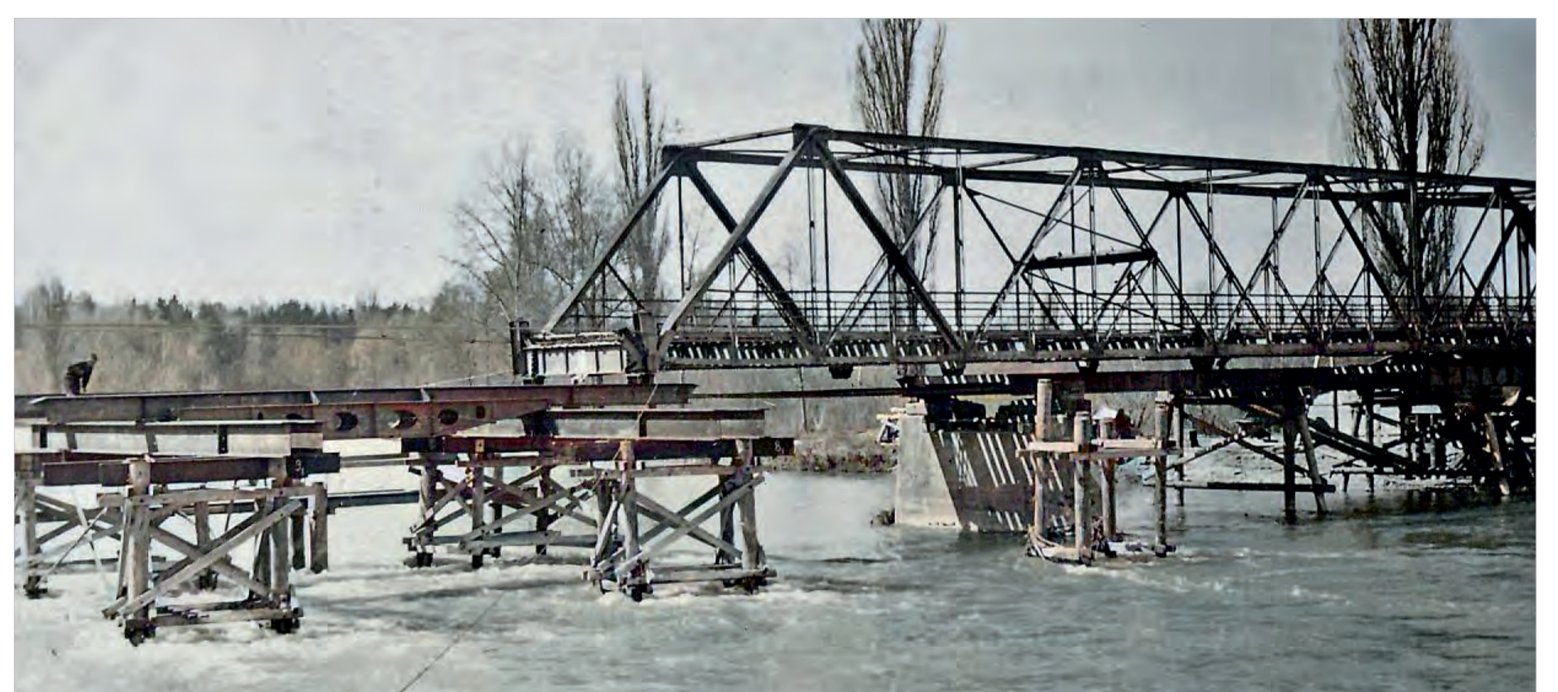
Der Wiederaufbau der Ettliger Isarbrücke erfolgte erst wieder 1947.
