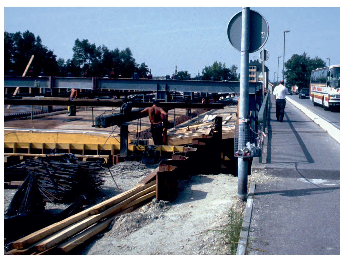
Der Neubau erfolgte parallel zur alten Brücken und wurde nach Fertigstellung 1993 „eingeschoben“.
