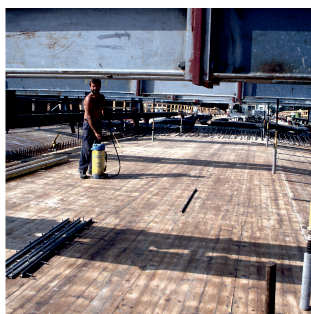
Shalungsbau für die neue Brücke im Jahr 1992.
