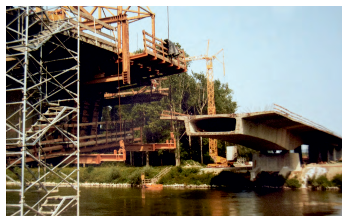
Überquerung der Isar wird fertiggestellt.
