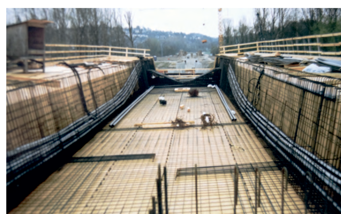
Schalungsbau der Brücke.
