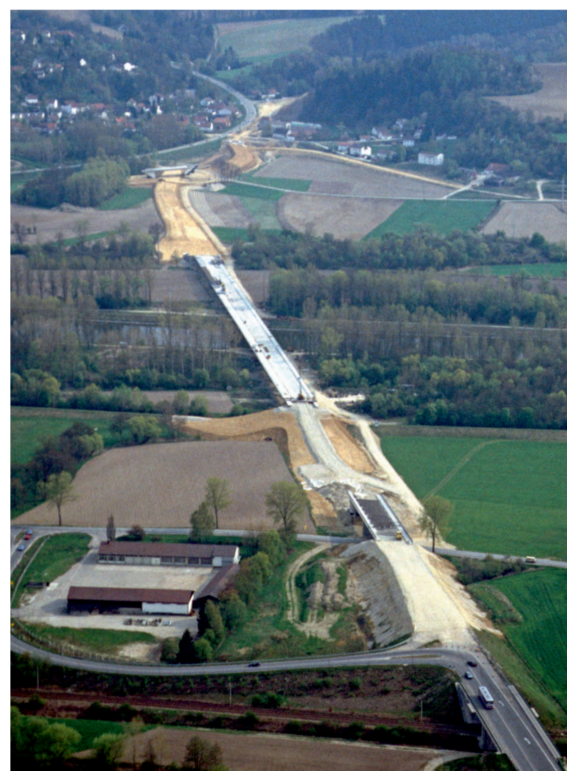
Luftansicht in der Bauphase der Ortsumfahrung.
